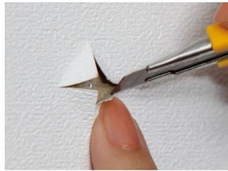
カッターの刃先で丁寧に壁紙をめくり、下穴をあける。壁紙を挟まないようにアンカーをねじ込む。
